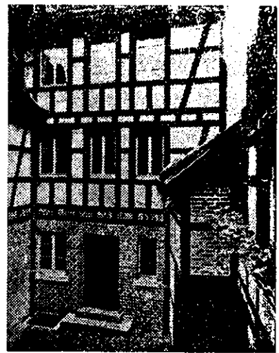
図15. リービッヒ生家の母屋の中庭側の写真(改修後)。
