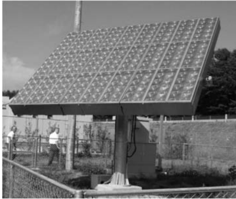
写真1 NEDO北杜サイト追尾型集光太陽電池モジュール(シャープ)
