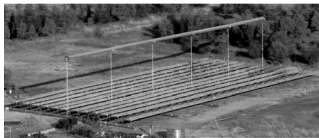
図7 リニアフレネル太陽熱発電システム概念図
