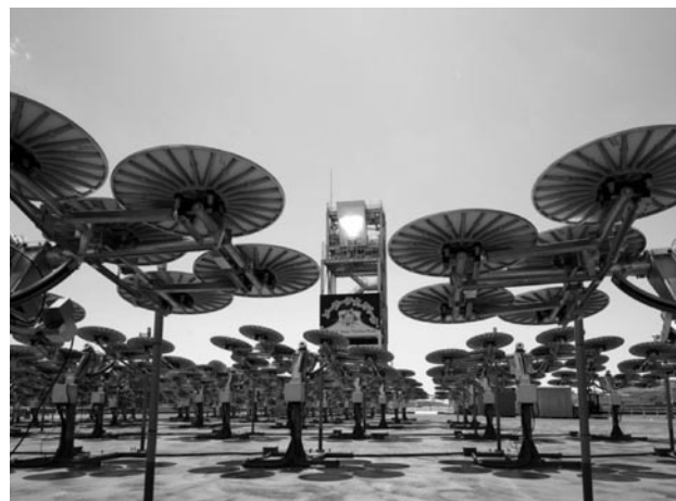
図10 太陽熱発電タワートップ方式システム写真
