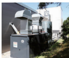
熱電併給ユニットで発生する熱を利用 して自家発電
