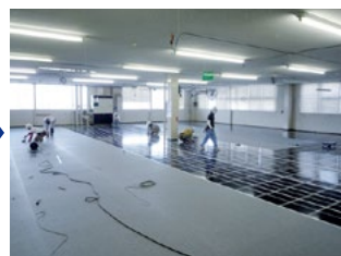
保護シートの敷設
