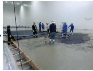
コンクリート打設
