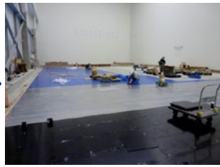
ミュースレーターの敷設
