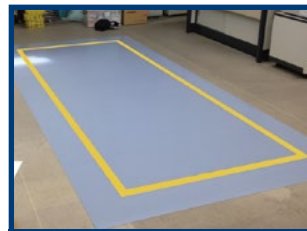
3 保護シートの施工
