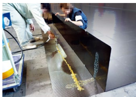
防水・防塵用グリスの注入
