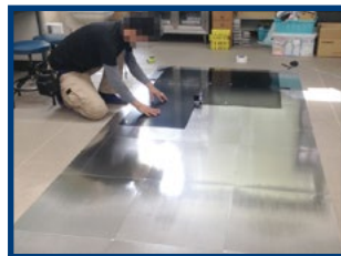
2 ミューソレーターの敷設
