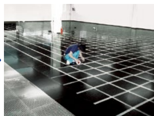
ミュソーレーターの敷設
