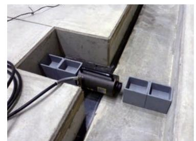
大地震発生後は、ピットに格納されている電動ジャッキで原点にリセットします。
