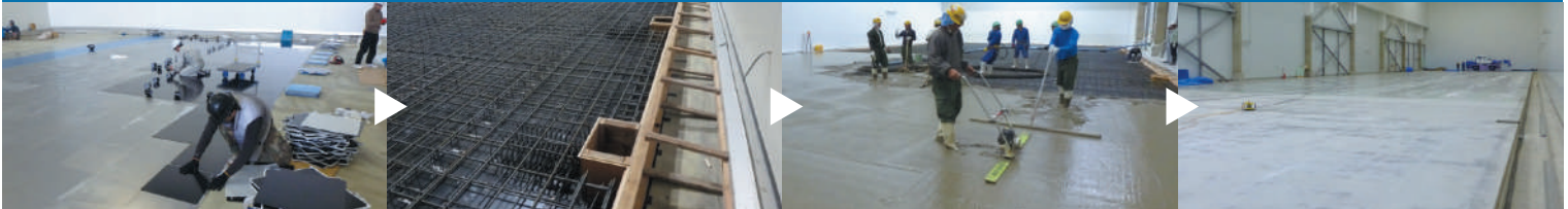
ミュソレーターの施工
