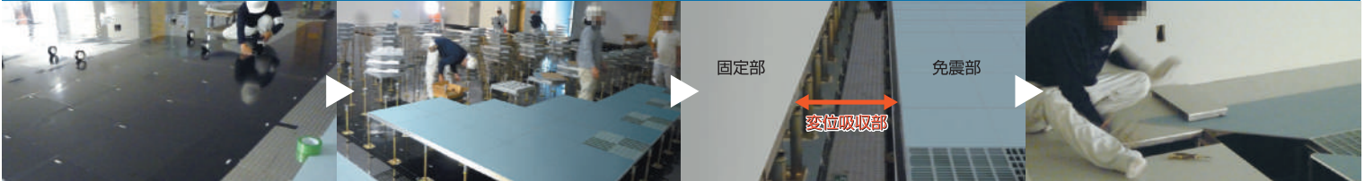
ミュソレーターの施工
