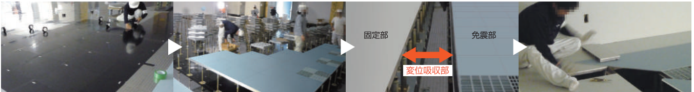
ミューソレーターの施工
