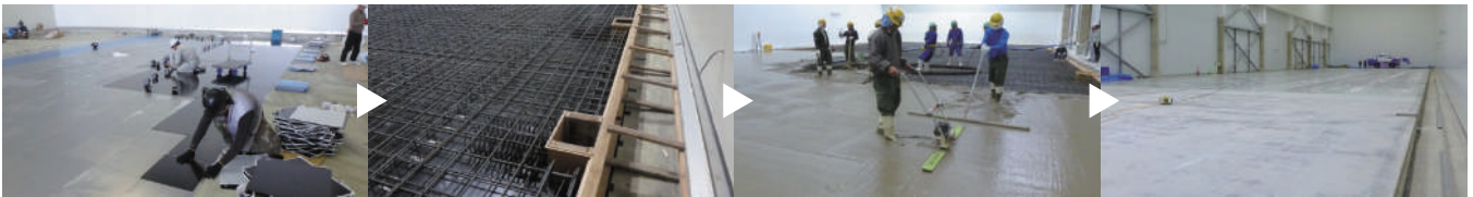
ミューソレーターの施工
