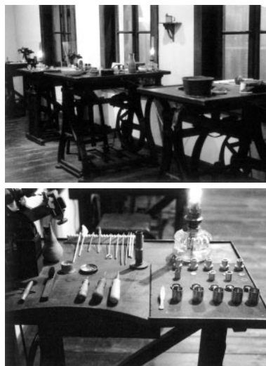
初期の工場内での種々の光学機器の組み立て作業場。
